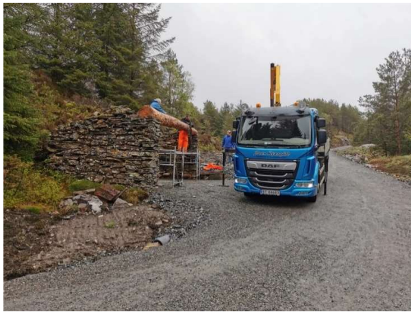
villmarkspanelen ferdig skåret.
